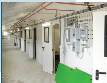
CHODBA S VNITŘNÍMI DVEŘMI A OKNY
