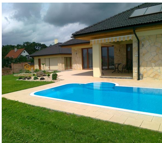
Bazén z materiálu Polystone® P-copolymer realizovaný společností ABPLAST s.r.o.
