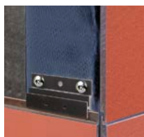
OTEVŘENÁ ROHOVÁ SPÁRA S PÁSKOU EPDM Obrázek 2
