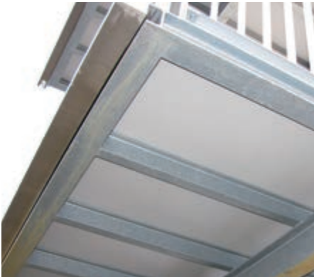
SPODNÍ KONSTRUKCE / NOSNÍKY
