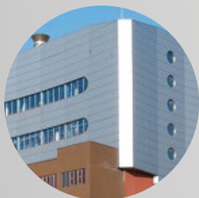
KOMPOZITNÍ FASÁDNÍ OBKLADY (ALUCOBOND)
